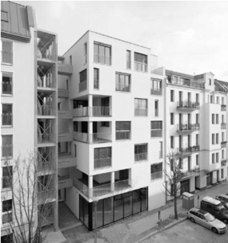
Das Projekt e3 ist Europas erste entstandene siebengeschoßige und 22 m hohe Holzkonstruktion in einem großstädtischen Zentrum. Bauzeit: 9 Monate. Holz wurde in erster Linie als Konstruktions- und Dämmmaterial mit besten bauphysikalischen Eigenschaften und einer hervorragenden Energiebilanz genutzt. Foto: Norbert Weber
